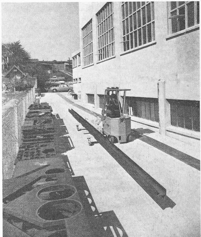
ten. Stapler für Normalpaletten können aber für das Lagern und Befördern von Langgut nicht oder kaum eingesetzt werden, einmal weil der Gabelabstand zu klein ist, um solchem Material sicheren Halt zu geben und zum anderen, weil Langgut auf den Gabeln eines Frontstaplers quer zur Fahrbahn liegt.
