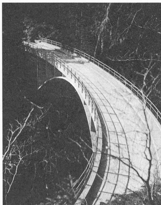
Arvebrücke bei Vessy (Genf), Spannweite 56 m. Erbaut 1936
