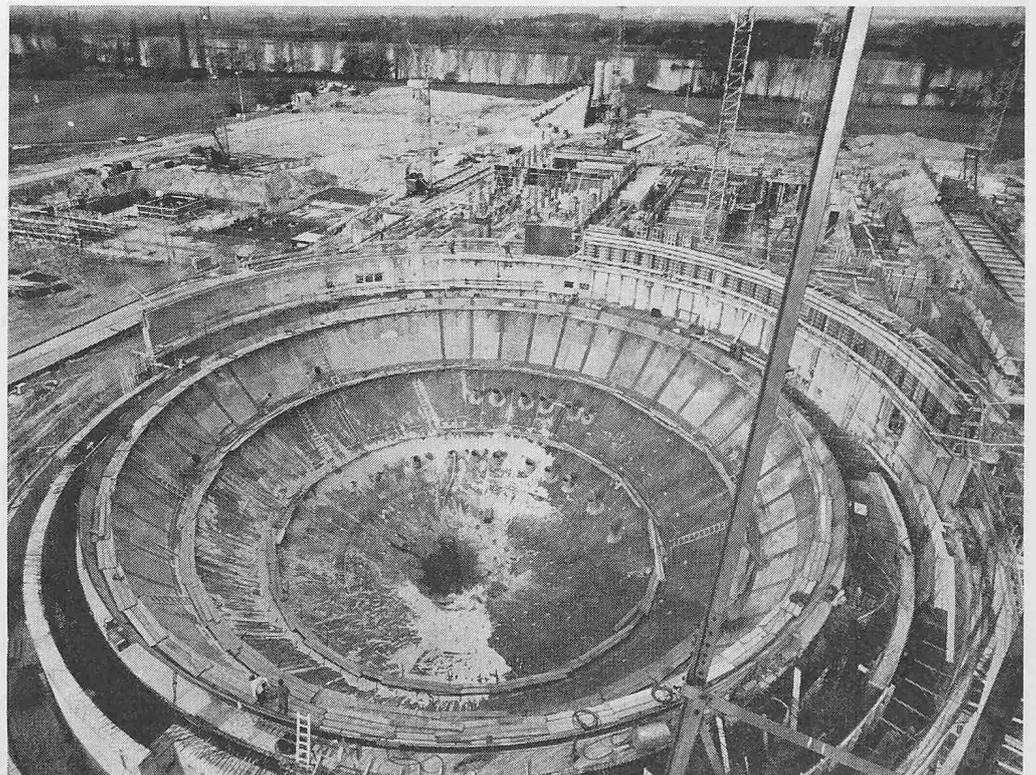
pressen des flüssigen Betons geschah von der Kugellinnen-seite her durch 471 dafür vorgesehene und im Behälter eingeschweisste Verpressstutzen.
