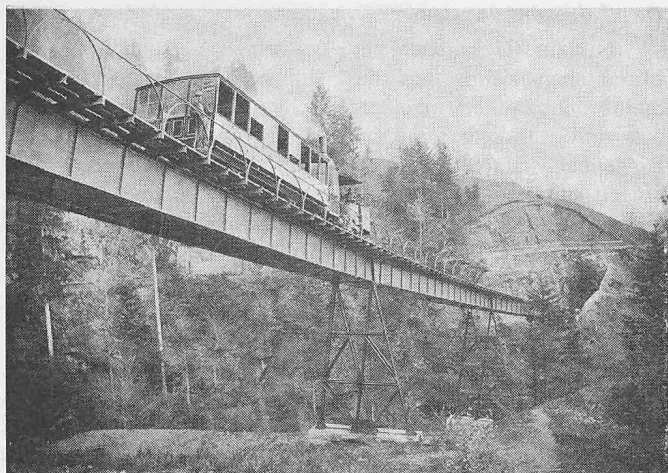
Bild 4. Schnurtobelbrücke im Originalzustand. Dampflokomotive mit stehendem Kessel
