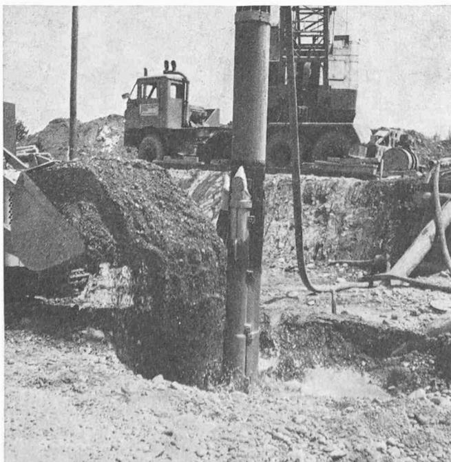
Lagerungsdichte aufweist, denn in locker gelagerten Zonen ist der Verdichtungseffekt natürlich sehr viel grösser als in bereits dichter gelagerten Zonen. Der Wirkungsbereich eines Rüttelpunktes hängt stark von der Bodenart ab und liegt im Maximum bei etwa 6 m<sup>2</sup>. Es ist zudem darauf zu achten, dass wirklich eine Vergrößerung der Verdichtungsfläche gegenüber der Fundamentfläche stattfindet (Bild 6).
