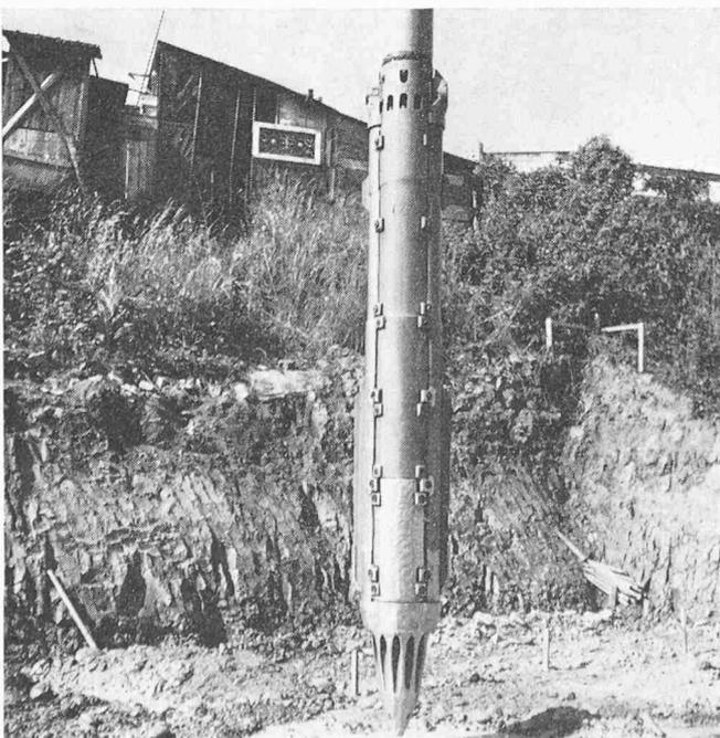
Bild 2. Torpedo-Rüttler mit Traggerät
