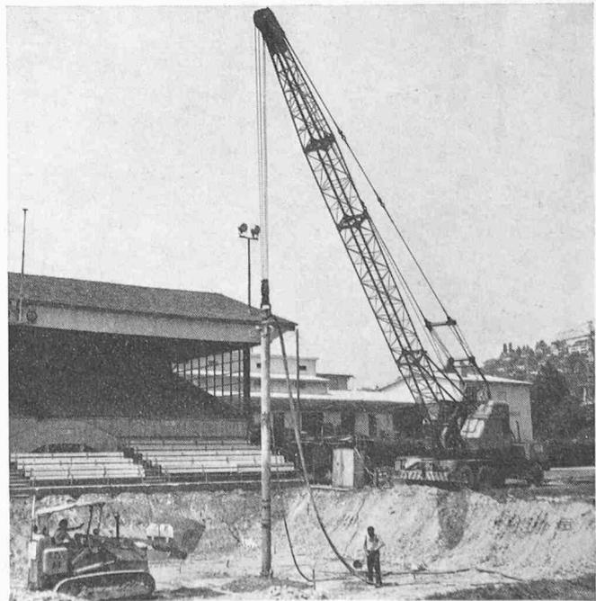
Bild 3. Verdichtungsvorgang beim patentierten Rütteldruckverfahren
