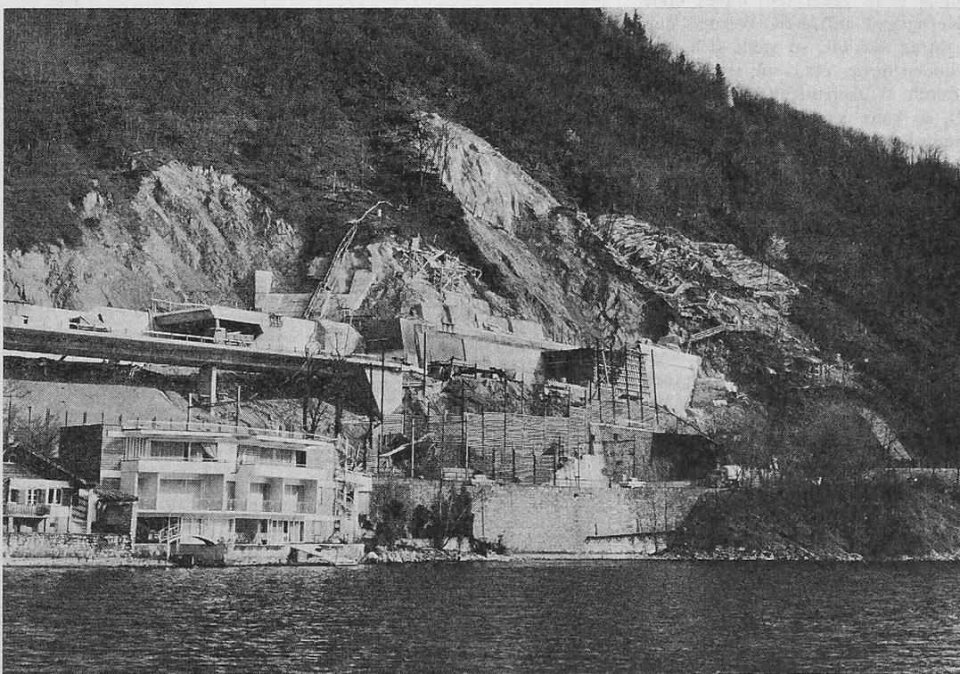
Bild 12. Übersicht über den Hang bei Bissone TI. Oben Portale der Autobahn, unten Portal der Schweizerische Bundesbahnen. Die kritische Zone ist die rechte obere Bildhälfte
