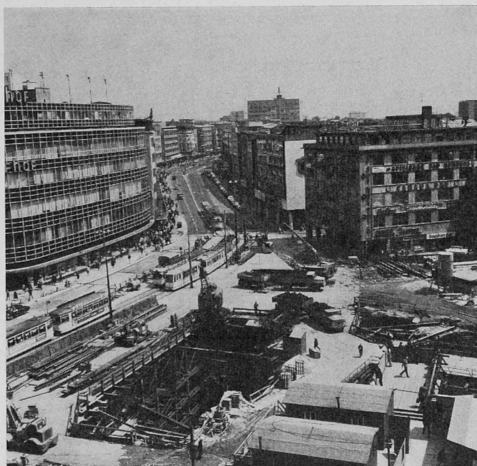
Bild 6. Provisorische Fahrbahnabdeckung und Strassenbahngleisabfängung über eine 21 m tiefen Baugrube «An der Hauptwache» in Frankfurt am Main
