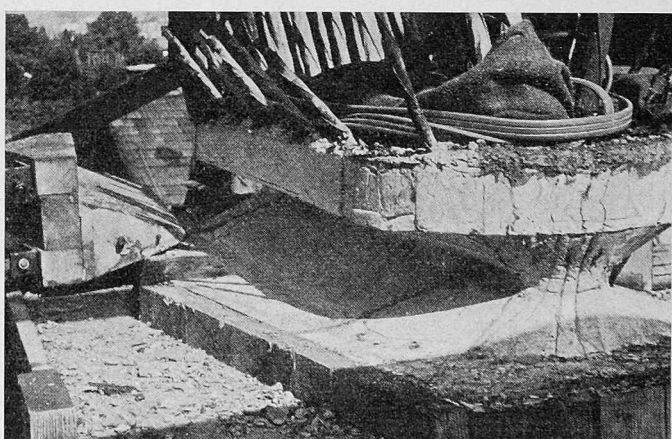
Bild 13. Betongelenk beim Hardturm-Viadukt beim Ausschalen
