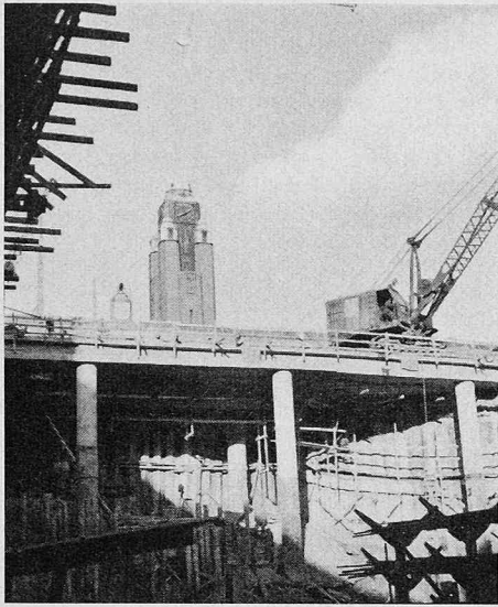
Bild 6. Blick unter die neue Strassendecke. Ausgeschaltete Betonpfähle, welche als Säulen dienen
