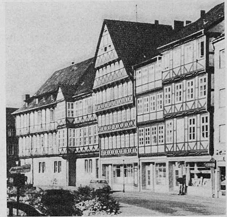
Hannover. Wiederaufgebaute Fachwerkhäuser
