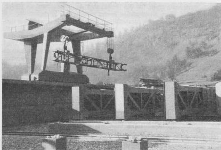
Bild 8. Dammbalkendepot mit Versetzkran
