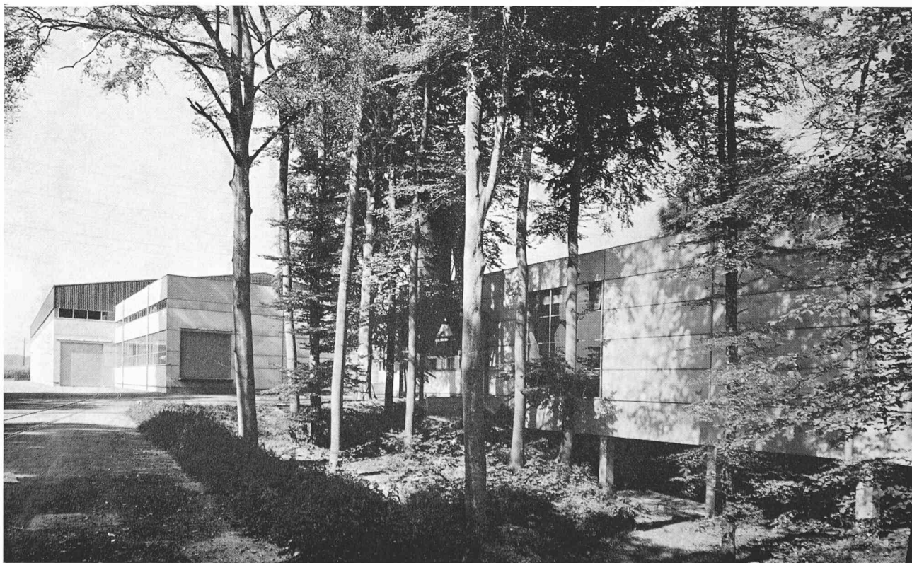
Bild 5. Ansicht von Südwesten
