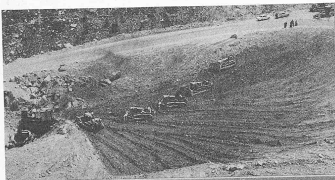
Bild 6. Oben: Bulldozer schieben Moränenmaterial zum Kolmann; unten: der Kolmann-Bandlader in Aktion
