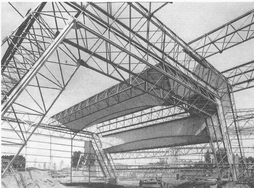
Links: Bild 1 (oben) Montage der Trapezrahmen, Bild 2 (Mitte) Montage der Fassaden-träger, Bild 3 (unten) teilweise verlegte Dach-haut der Prototyp-Halle
