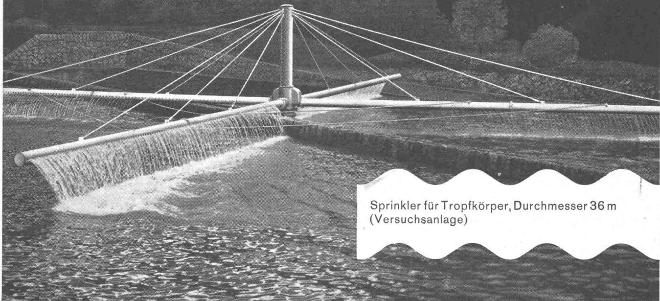
Sprinkler für Tropfkörper, Durchmesser 36 m
