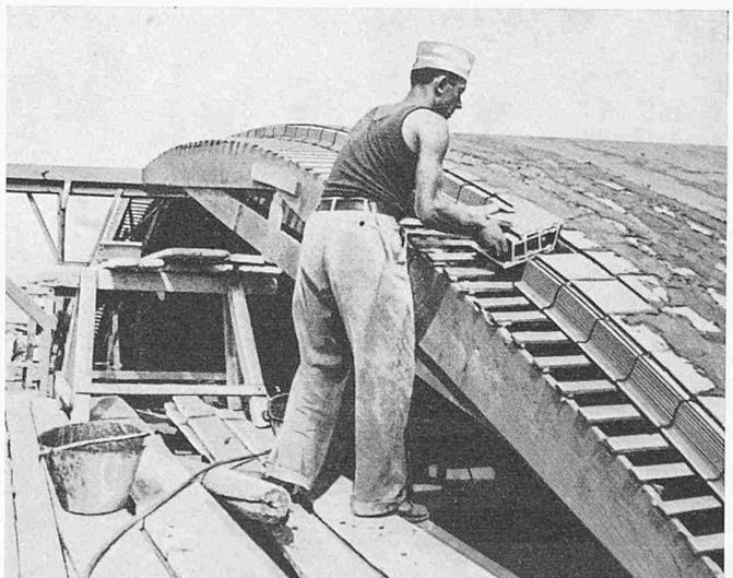
Bild 15. Ausführung der Schale mit einer beweglichen Lehre
