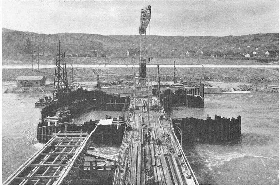
Bild 58. Hilfswehr. Baugrubenumschliessung für Wehröffnung 2. 3. April 1952
