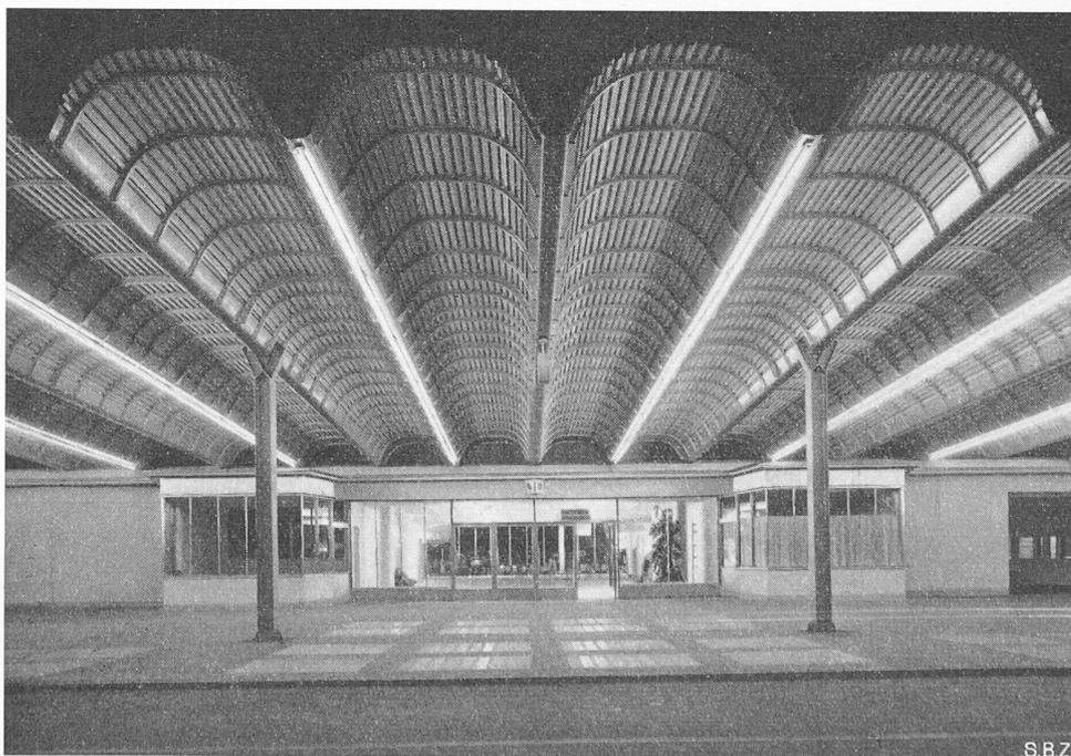
Bild 46. Neonbeleuchtung des Aluminiumvordaches
