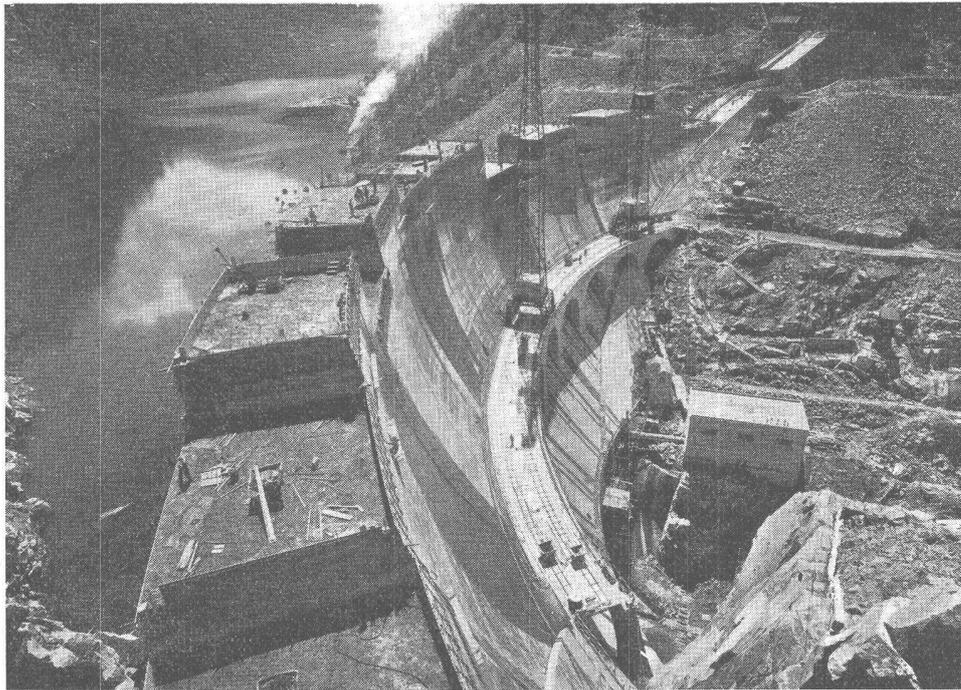
Staumauer Forte Buso in der Provinz Trento (Italien). 140 000 m<sup>3</sup> FRIOPLAST-Beton (die ersten 120 000 m<sup>3</sup> wurden mit einem gewöhnlichen Air-entrainer ausgeführt)
