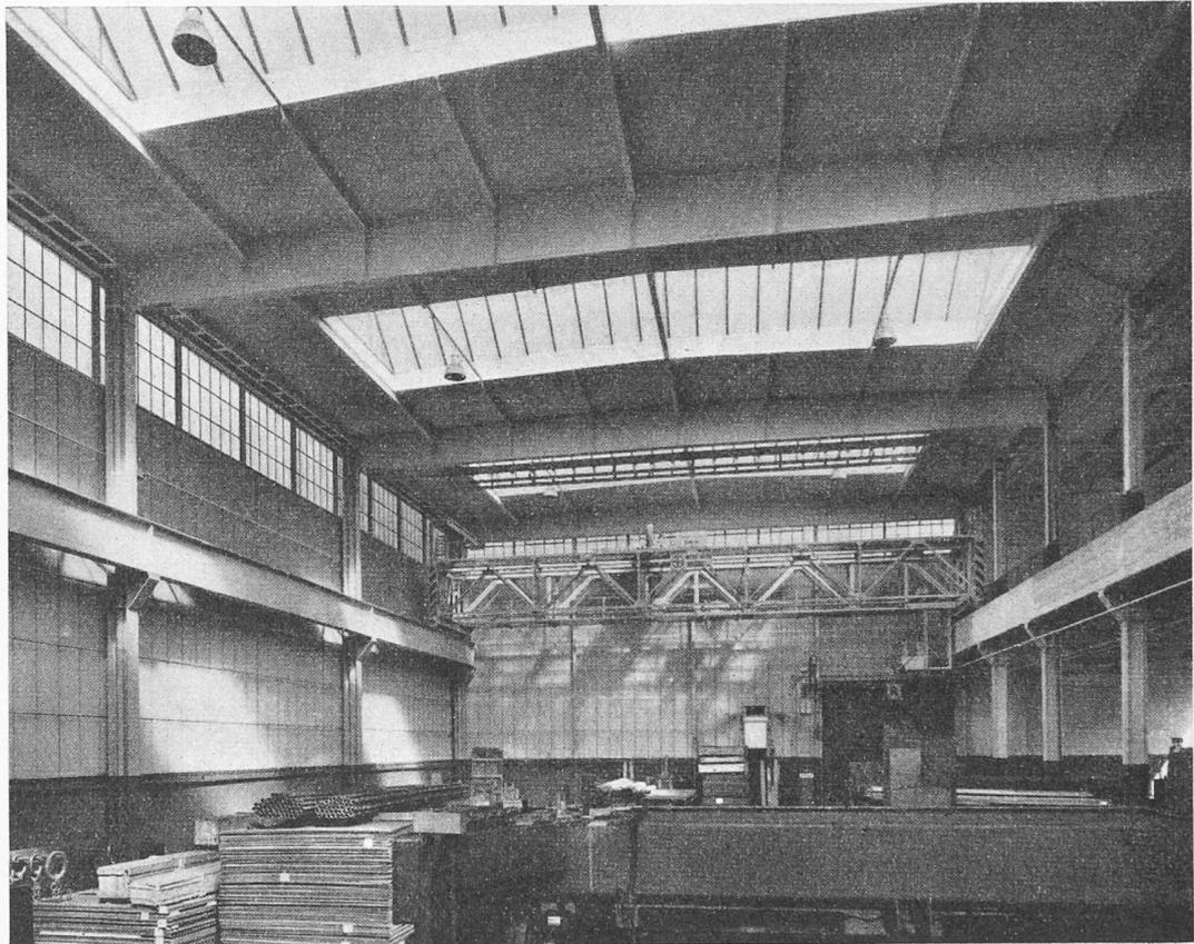
Bild 1. Blick in die Bearbeitungshalle; rechts Eisenbetonbrüstungsträger als Kranbahnträger
