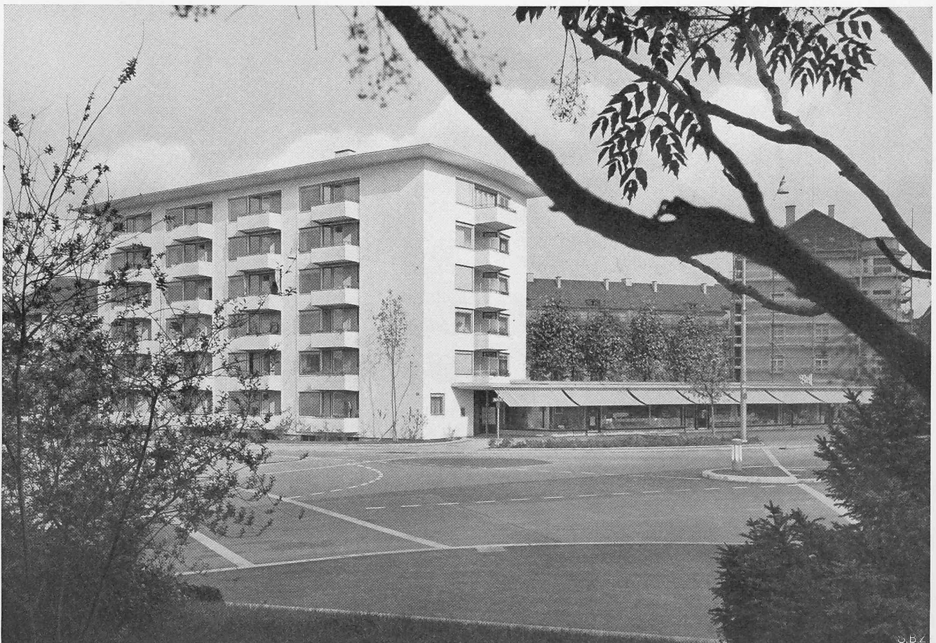
Wohnblock an der Bertastrasse aus Südwesten, im Hintergrund die alte Bebauung, davor Grünanlage im Innenhof
