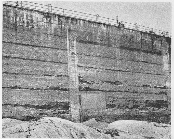
Bild 15. Frostschäden an der Wasserseite einer Staumauer
