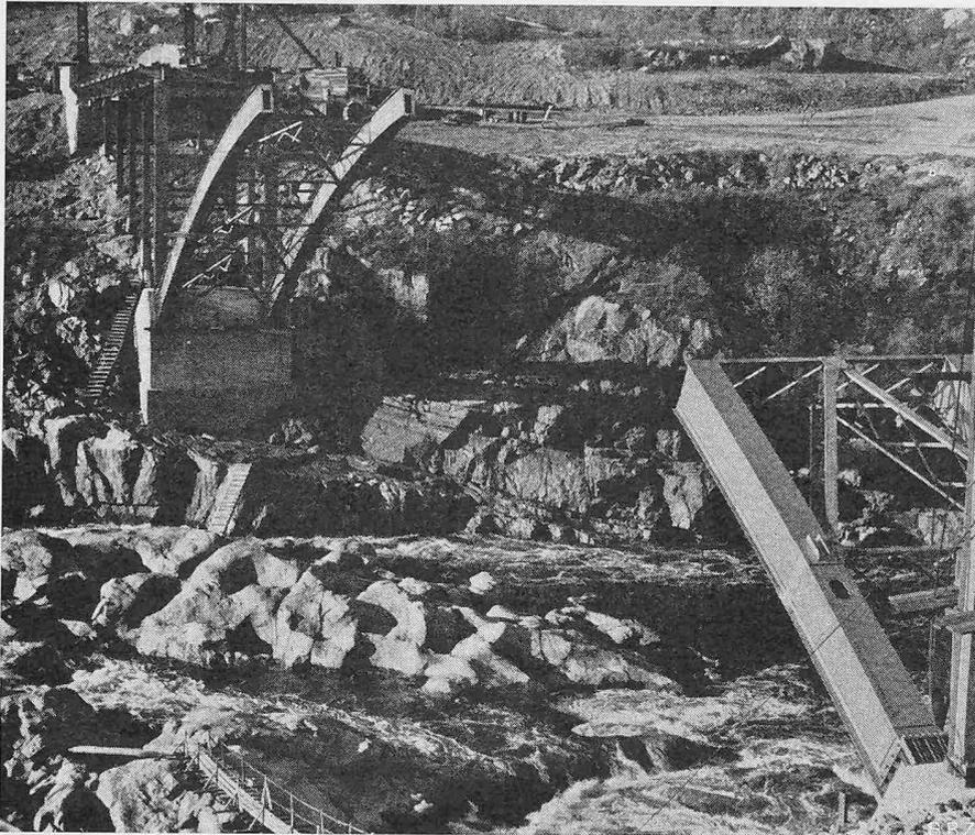
Bild 14. Bogenbrücke bei Arvida (Canada) im Bau
