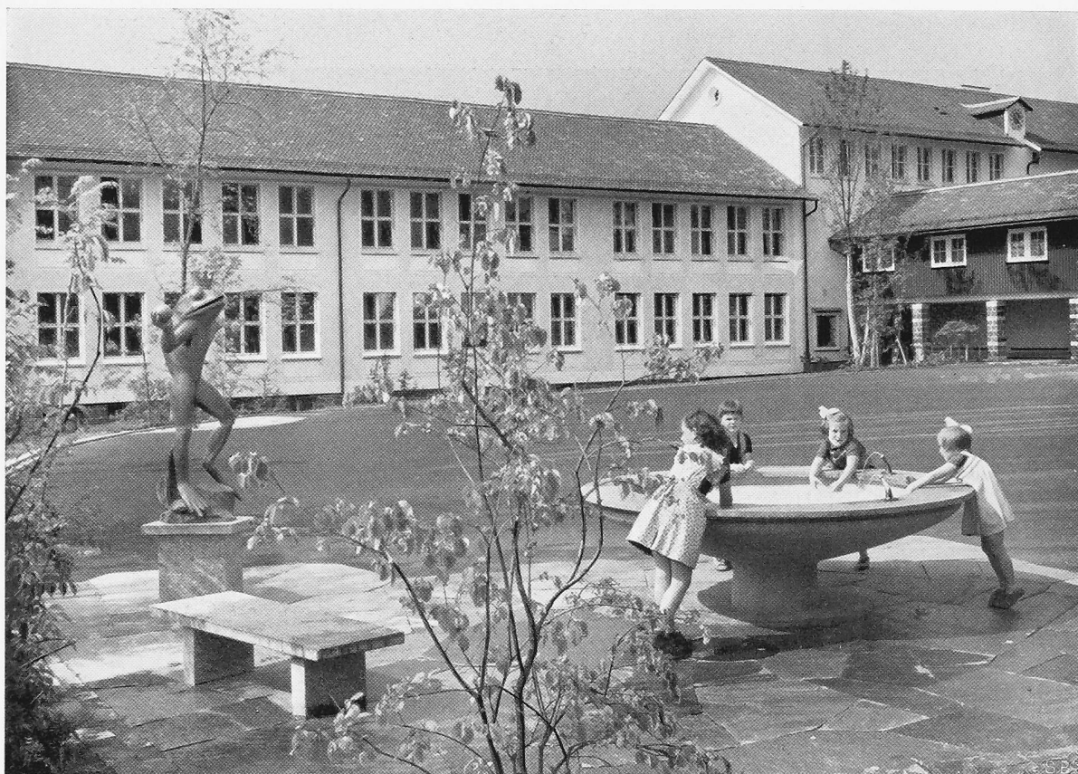
Bild 17. Pausenplatz der Unterstufe aus Süden
