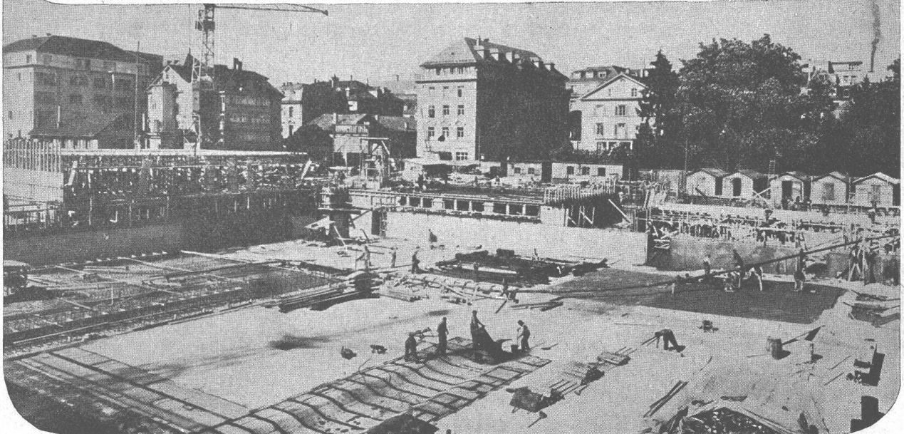
Grundwasserisolierung Neubau „Claridenhof“ Zürich, ca. 5000 m<sup>2</sup>
