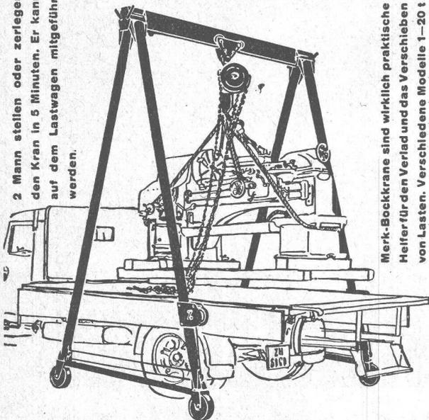
Merk-Bockkrane sind wirklich praktische Helfer für den Verlad und das Verschieben von Lasten. Verschiedene Modelle 1-20 t Tragkraft verschiedener Höhen und Breiten. Verlangen Sie nähere Angaben.
