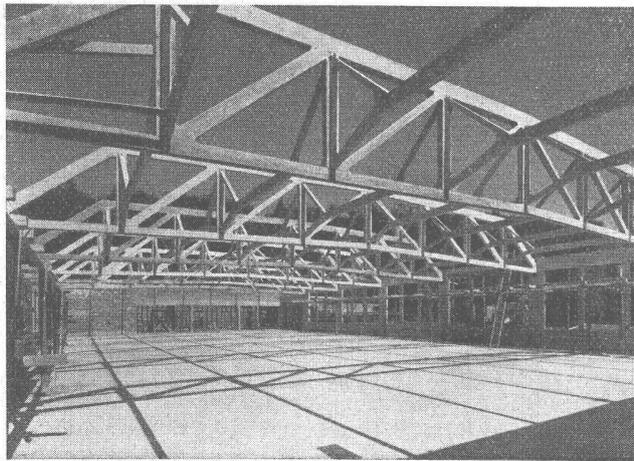
Eisenbetonfachwerk - Montagefertig
