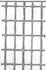
**Drahtziegelgewebe und Streckrabitz** die beiden bevorzugten Putzmörtelträger
