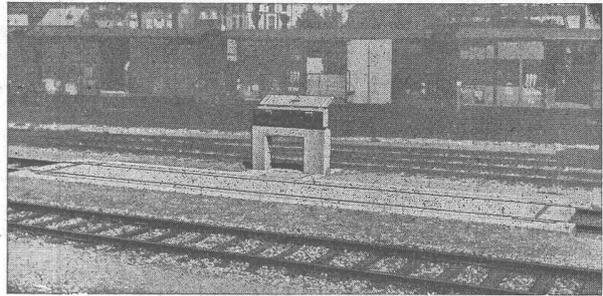
Brückenwaage für Geleisefahrzeuge, Wiegefähigkeit 70 t. Normaltyp SBB mit armierter Betonbrücke in Rippenkonstruktion, Länge 11,6 m
