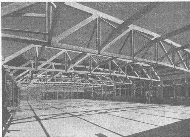
Eisenbetonfachwerk - Montagefertig
