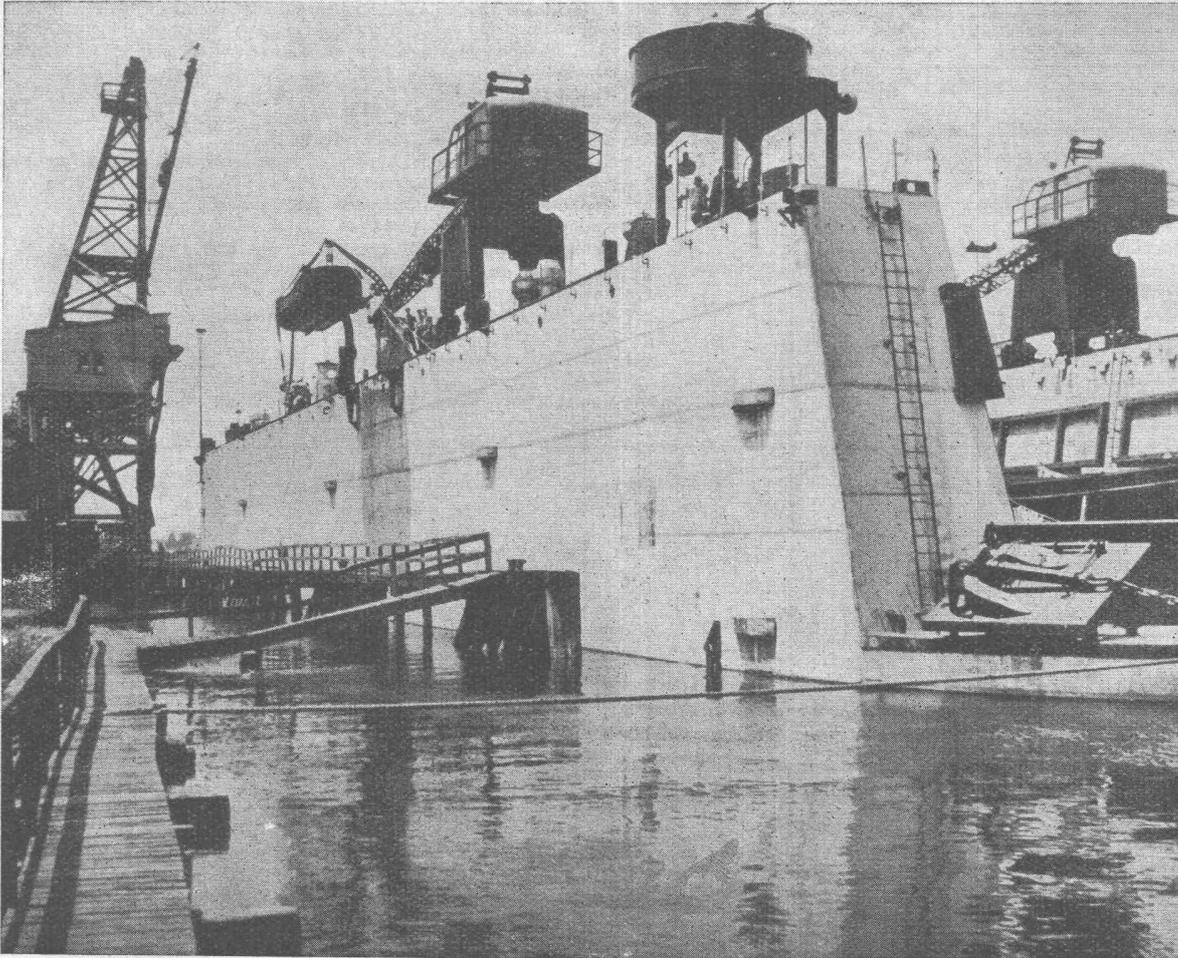
Eisenbeton-Schwimmdock U. S. A. mit Plastiment-Zusatz
