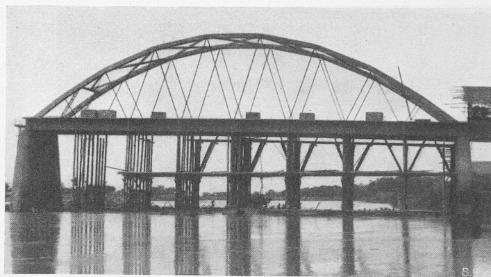
Bild 33 und 34. Erste Hauptöffnung der Brücke in Nakhon Sawan nach dem Hochpressen der Fahrbahn
