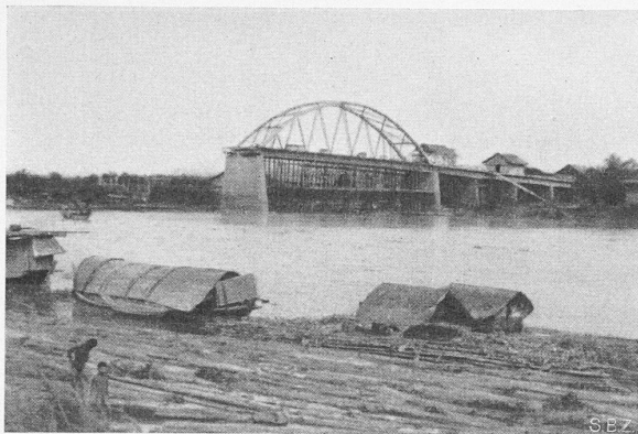
Bild 33 und 34. Erste Hauptöffnung der Brücke in Nakhon Sawan nach dem Hochpressen der Fahrbahn
