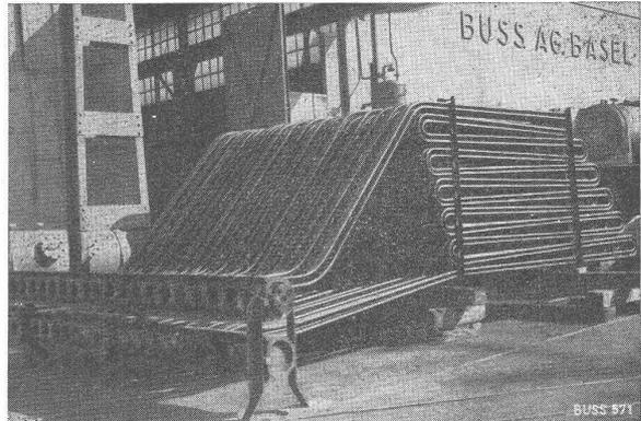
Ueberhitzer für einen Steilrohrkessel 500 m<sup>3</sup>, 34 Atü, 425° C Dampf-Temperatur, Rohrschlangen in Speziallegierung
