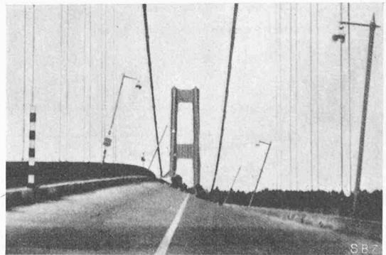
Abb. 2. Drehschwingungen der Fahrbahn Tafel
