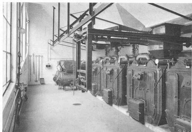
Abb. 20. Heizung mit Beschickungs-Laufkran verbunden mit Waage
