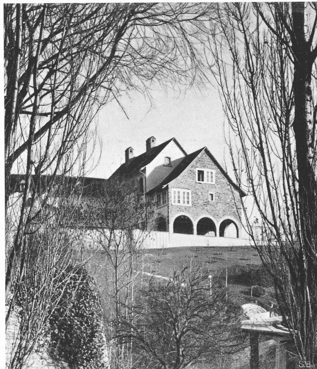
Abb. 2. Ansicht aus Westen, von der Zürichstrasse aus
