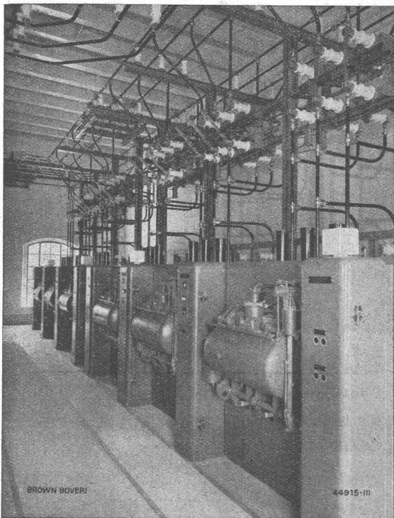
A.-G. Elektrizitätswerk Wynau-Langenthal (Schweiz), Zentrale Wynau. — Zehn Druckluft-Schnellschalter 400 A, Betriebsspannung 9,5 kV, Nennspannung 24 kV, Abschaltvermögen 250 MVA bei 9,5 kV wiederkehrender Spannung.
