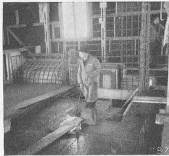
Abb. 12. Betonieren der Decke über I. St., l. hinten Thermometer-Nische
