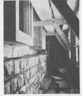
Abb. 14. Betonierte Fenster- und Vormauerung
