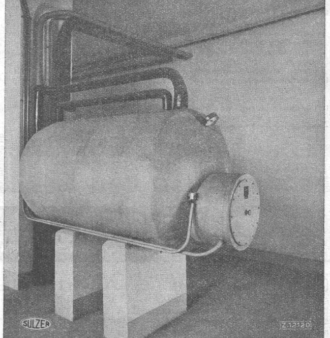
Ein Boiler zur Erwärmung von Wasser für allseitigen Gebrauch. Derselbe erfolgt hier nicht nur mit Dampf, Warm- oder Heißwasser, sondern wechselweise auch durch elektrischen Strom. Der Boiler besitzt auch einen elektrischen Heizeinsatz vorzugsweise zur Ausnützung von billigem Nachtstrom.
