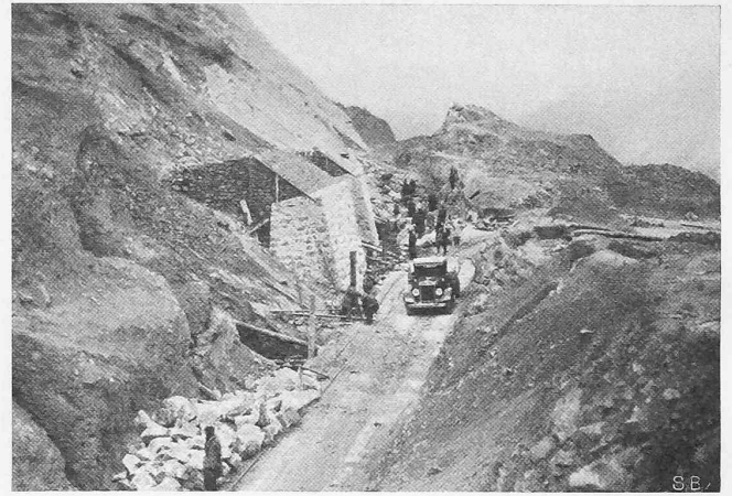
Abb. 5. Einschnitt bei Km. 190,5.
