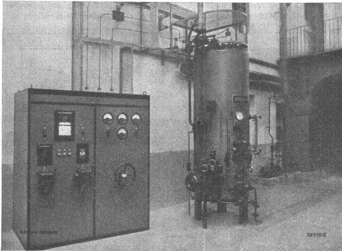
Wasserstrahl-Elektrokessel, 1000 kW, 6000 V, 6 kg/cm<sup>2</sup> abs.
