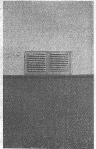
an einer Aussenwand darf der Automat nicht befestigt sein, weil Aussenluft im Winter Einfriergefahr mit sich brächte. Die Luftentnahme im anstossenden Raum wird durch eine Art fester Jalousie, ebenfalls in der Grösse 15 × 30 cm abgedeckt (Abbildung). Die schönen, bis auf die Öffnung für die Bedienung der
