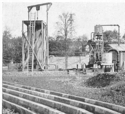
Abb. 2. Gesamtbild der Versuchsanlage.
