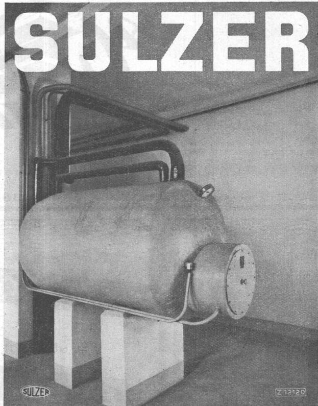
Ein Boiler zur Erwärmung von Wasser für allseitigen Gebrauch. Derselbe erfolgt hier nicht nur mit Dampf, Warm- oder Heißwasser, sondern wechselweise auch durch elektrischen Strom. Der Boiler besitzt auch einen elektrischen Heizeinsatz vorzugsweise zur Ausnützung von billigem Nachtstrom.
