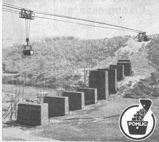
**Pohlig-Kabelkrane** finden als billiges u. betriebseinfaches Fördermittel Verwendung zur Lagerplatzbedienug, in Steinbrüchen, zur Schiffsentladung, im Schiffbau, bei Erdbewegungen, beim Bau von Talsperren und von Eisenbahnüberführungen.
