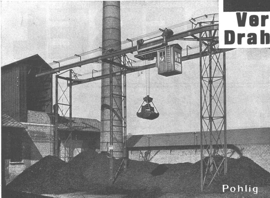
Das Bild veranschaulicht eine Elektrohängebahn mit Führerstandskatze und Zweiseilgreifer für Kesselbekohlung. Stündliche Leistung: 14 t Braunkohle.
