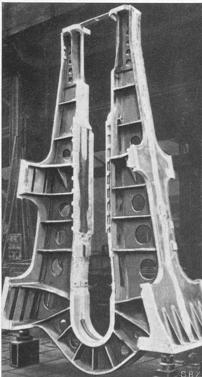
Abb. 7. Geschweisster Rahmen zum Motor Abb. 5.
