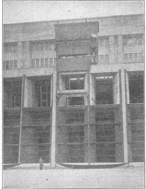
Energie Electrique du Rhin. Kraftwerk Kembs. Rechenreinigungsmaschine.
