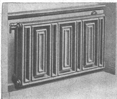
Beste Ausführung erfordert Wandflüsse und verdeckte Anschlüsse Spezialhahn und Rücklauf-Ver-schraubung
