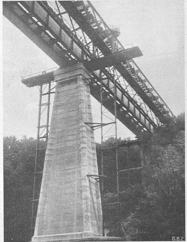
Abb. 2. Neuer Träger eingeschoben, ummantelter alter eiserner Pfeiler.
