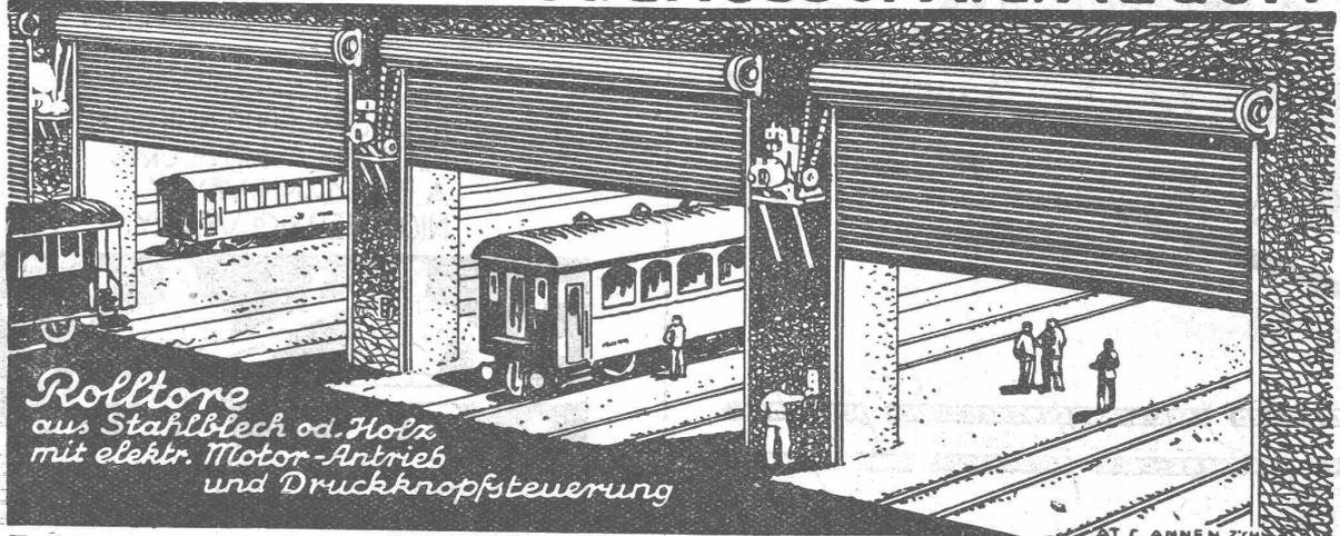
*Rolltore aus Stahlblech od. Holz mit elektr. Motor-Antrieb und Druckknopfsteuerung*
